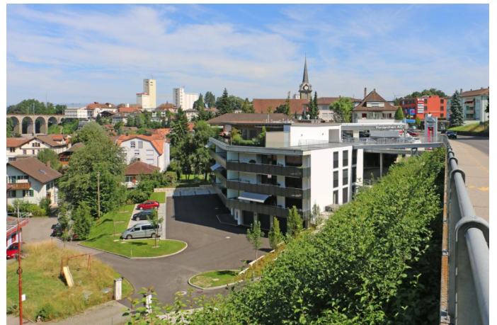
Sicht von Brücke
